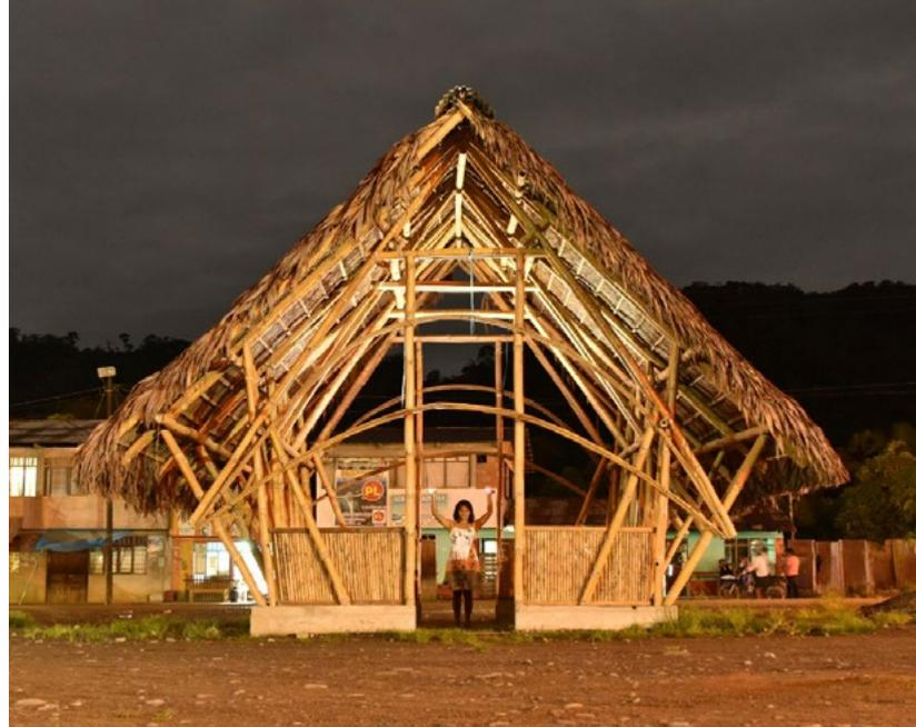
El módulo destinado a brindar información turística y promoción de artesanías tiene un área interior de 20 m<sup>2</sup> (4m x5m). La estructura de bambú está conformada por **cuatro pares de cerchas** sujetas entre sí por vigas de amarre, los cerramientos compuestos por postes -elementos verticales arriostrados con listones bambú en diagonal para el caso de los laterales y para las caras frontal y posterior arriostradas con dos arcos conformados por listones de bambú curvos.
